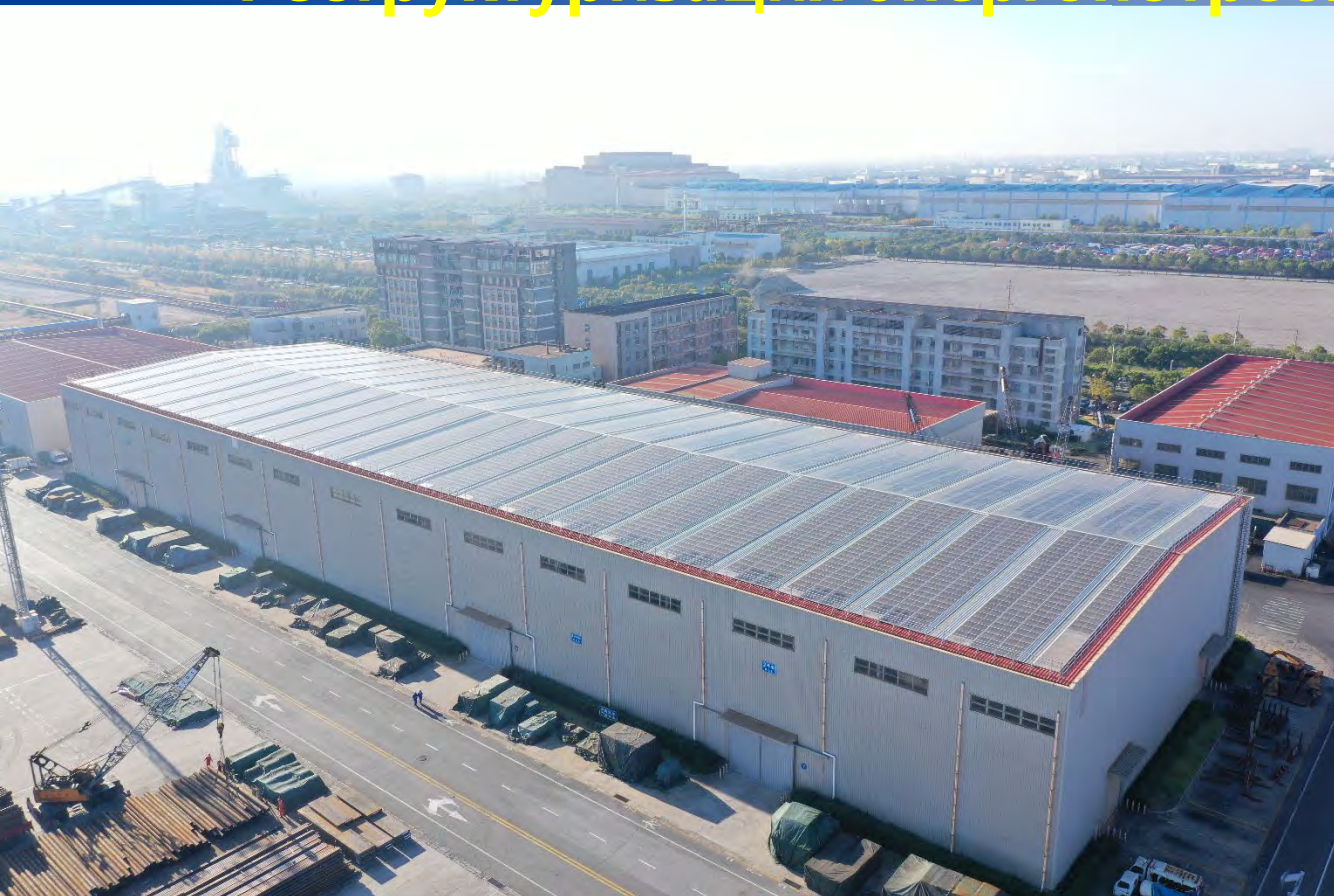
Портовый склад Крышные фотоэлектрические установки
